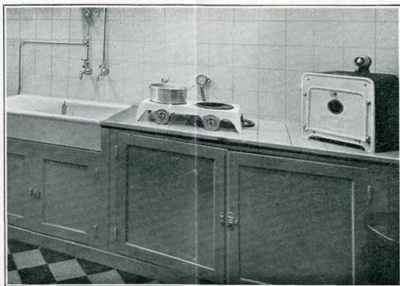
Fig. 5. — Installation de 30 hW avec four 800 W Lemercier. Réchaud Salvis.
